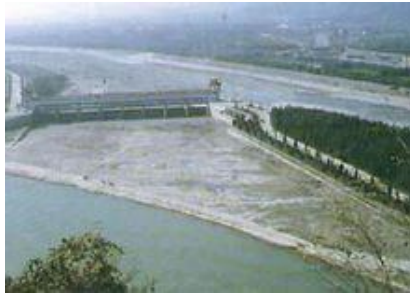
飛沙堰（溢洪排沙工程）。
