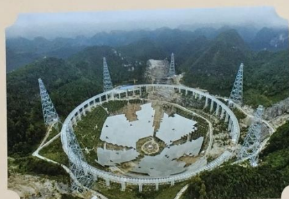
2015 年 8 月 2 日安裝第一塊單元反射面板
